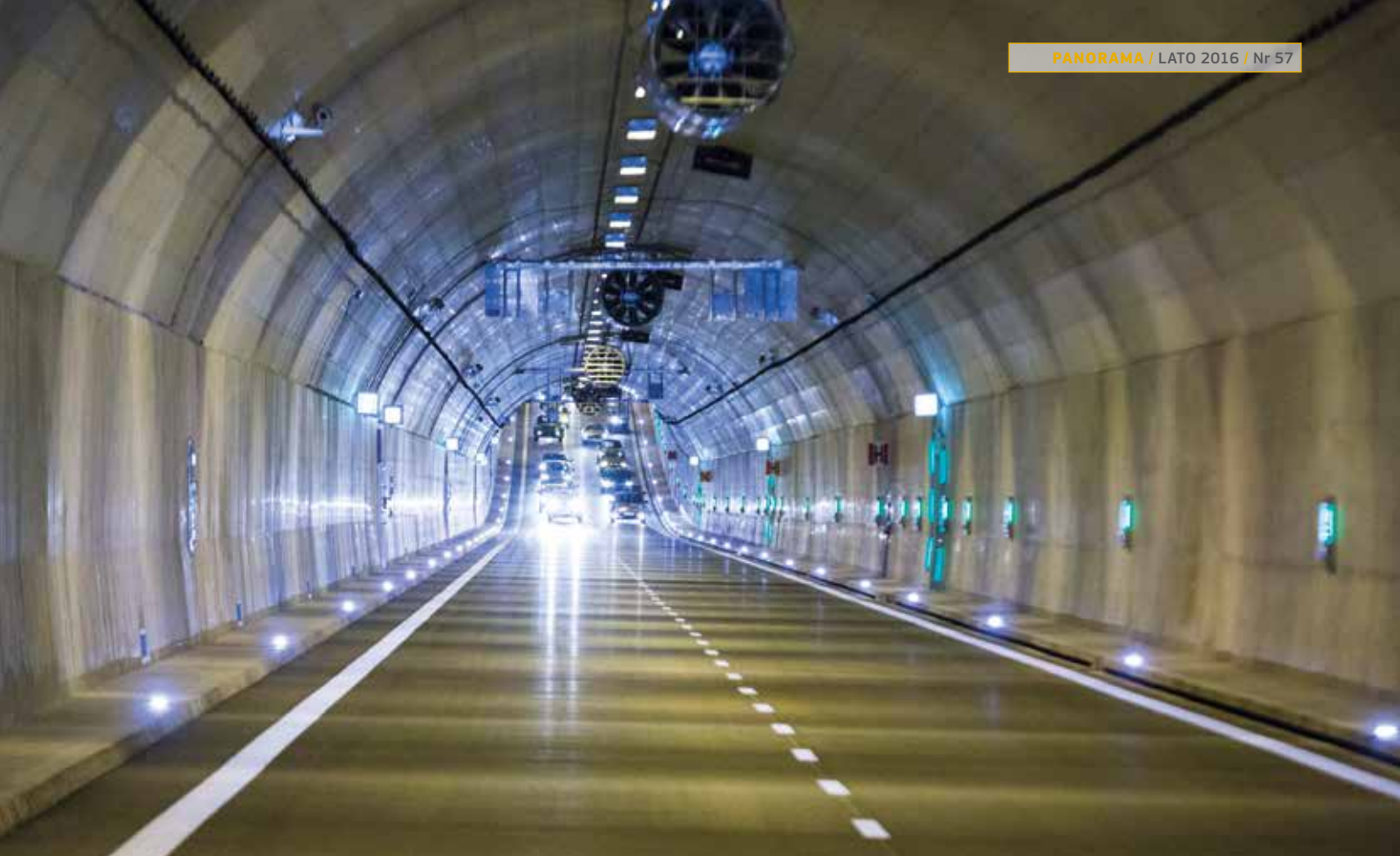
Tunel drogowy pod Martwą Wisłą
